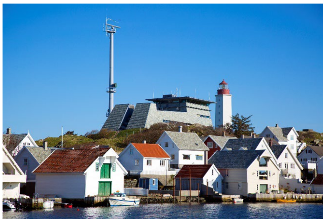
Bilde 53: Kvitsøy VTS (Foto: Ove Sveinung Tennfjord/Randaberg kommune)
