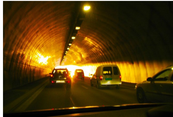
Bilde 59: Auglendstunnelen (Foto: Ove Sveinung Tennfjord/Randaberg kommune)
