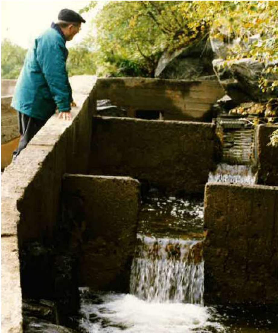
Valokuva 16. Suomalainen kalaportaan tekninen tarkastaja Eero Kajosaari ihmettelee kalaportaan altaiden mataluutta ja arvioi porrassaukkoon viritetyn mekaanisen kalalaskurin toimintaa. Valokuva Kjell Moen.
