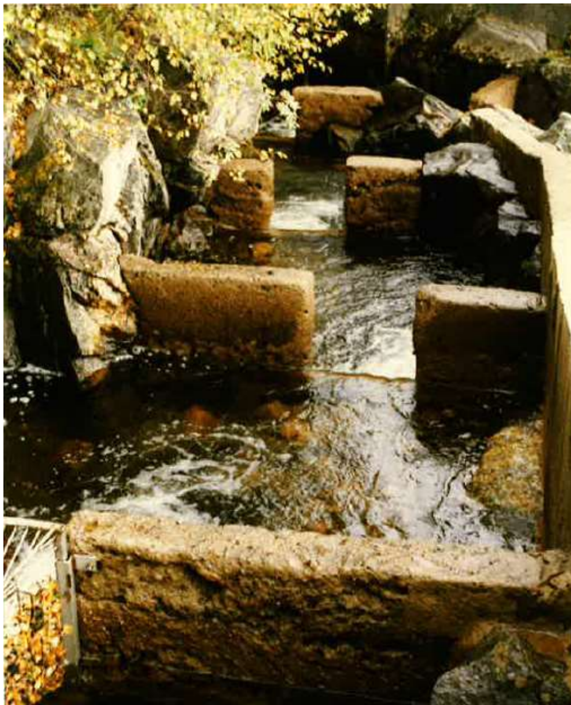
Valokuva 11. Kuva kalaportaasta vuonna 1996. Portaaseen ei oltu tehty muutoksia sen jälkeen kun se valmistui syksyllä 1967. Vuonna 1982 jäät rikkoivat joitakin porrasaskelmien väliseiniä ja vauriot korjattiin. Valokuva Kjell Moen.
