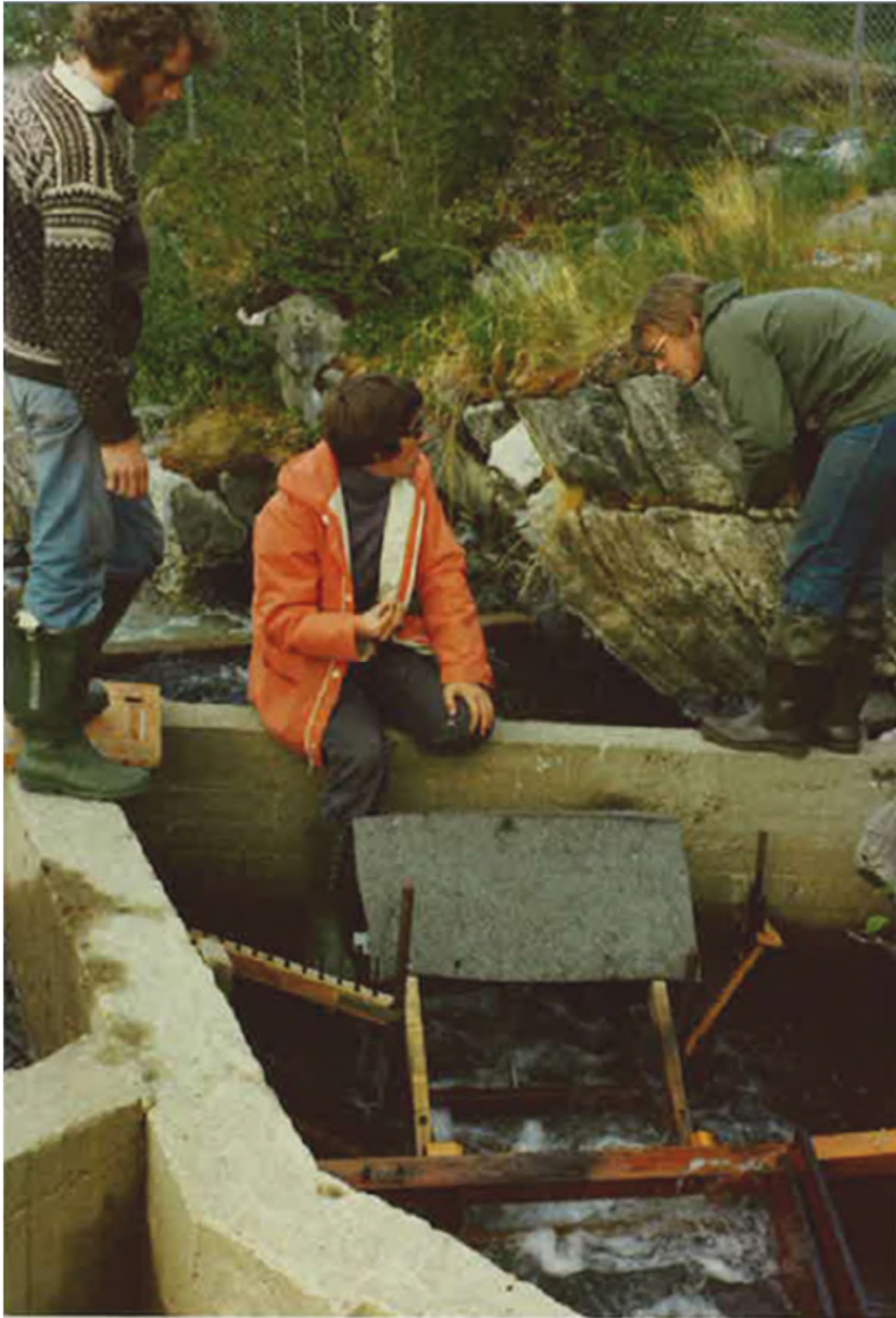
Valokuva 35. Kolttaköncäeseen asetetun mekaanisen kalalaskurin, paikallisten nimittämän "härvelin", toiminnan tarkistus vuonna 1976. Kuvassa vasemmalla Arne B. Vaag, keskellä Vilhelm Bjerknes ja oikealla Pekka Tuunainen. Kuvaaja tuntematon.
