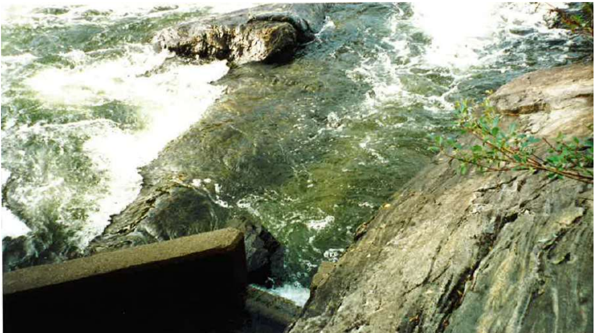
Valokuva 21. Elokuussa vuonna 2000 kalaportaan teknisen tarkastamisen yhteydessä estettiin veden virtaus portaisiin lähes kokonaan. Kuvasta nähdään, että alimman porrasaskelman alapuolella (kuvan oikeassa reunassa kallion kupeessa) oleva luonnontilainen monttu ei ole kovin syvä eikä laaja. Näin vähäisellä Näätämojoen virtaamalla lohien nousuhalukkuus ylempään lepomonttuun kuvan keskellä
