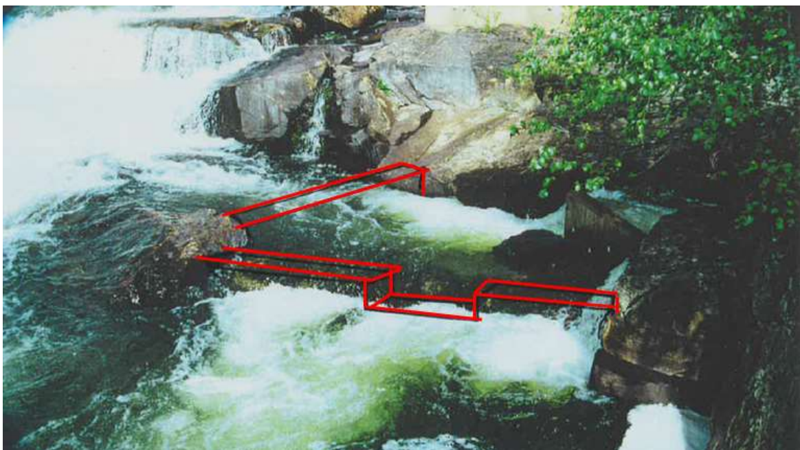
Valokuva 27. Kuva ehdotuksesta lohiportaan alaosan lisäaskelman tekemiseksi. Kuva on otettu ylävirtaan päin. Valokuva Carnie Consultancy -konsulttiyhtiön laatimasta raportista. Valokuvassa on punaisella värillä vahvistettu esitettyjä altaiden reunoja.
