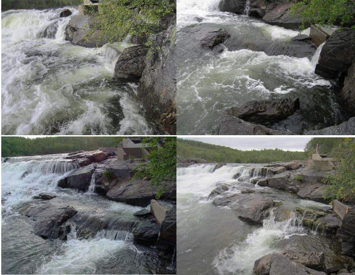
Valokuvat 71–74. Lohien mahdollisuudet hakeutua Näätämöjoen Kolttaköngkään oikealle puolelle rakennetun kalaportaan suuaukolle vaihtelevat eri vedenkorkeuksilla. Vielä tulvan loppuvaiheessa virtaaman ollessa suuri, on lohien helpompi hakeutua portaaseen kuin virtaaman pienennyttyä heinäkuun lopulla ja matalimman veden aikaan elokuulla. Kuvat Eero Niemelä.
