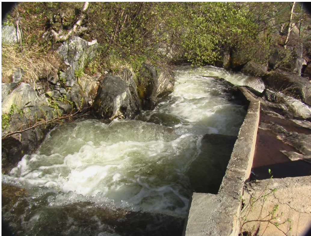
Foto 49. For stor vannføring i fisketrappa gjør laksens oppvandring gjennom trappa vanskelig. Foto Eero Niemelä.
