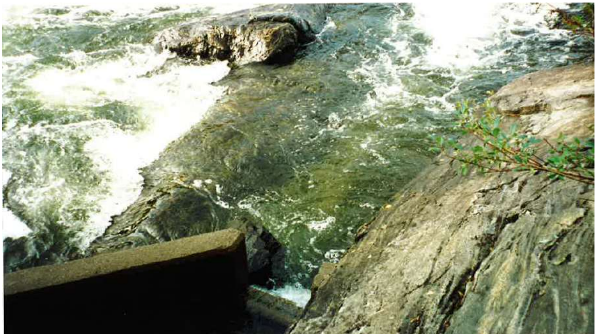
Foto 21. I forbindelse med en teknisk inspeksjon av trappa i august 2000 ble vannstrømmen til trappa stoppet nesten helt. Man kan se på bildet at den naturlige fordypningen nedenfor den
