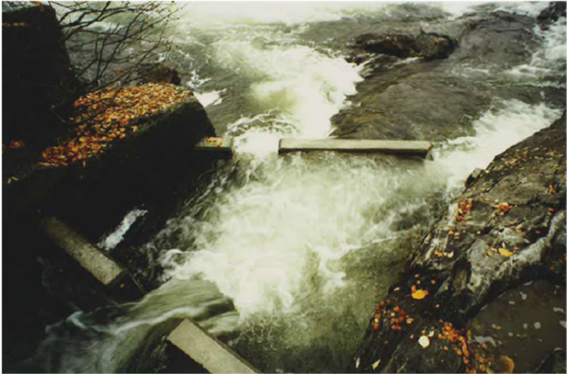
Foto 20. Vannmengden den 4. november 1997 i den lille kulpen nedenfor trappa (øverst til høyre på bildet) ville være tilstrekkelig i juli-august for at små og mellomstore laks kan vente der før de går opp trappa. Foto Kjell Moen.
