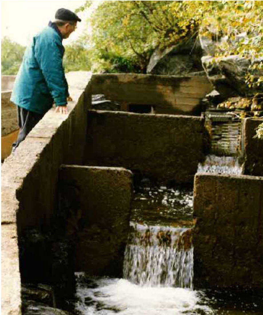
Foto 16. Den finske tekniske fisketrappinspektøren Eero Kajosaari undres over hvor grunne kulpene i fisketrappa er, og vurderer hvordan den mekaniske fisketelleren fungerer. Foto Kjell Moen.
