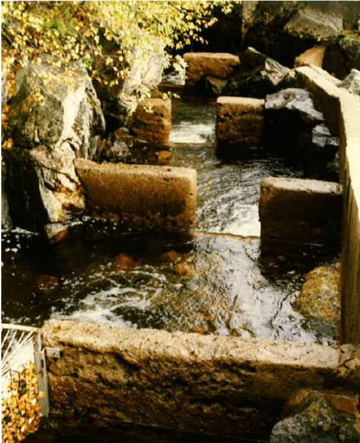
Foto 11. Fisketrappa i 1996. Det var ikke gjort endringer i trappa etter at den ble ferdig høsten 1967. I 1982 knuste isen noen av skilleveggene mellom kulpene, og skadene ble reparert. Foto Kjell Moen.
