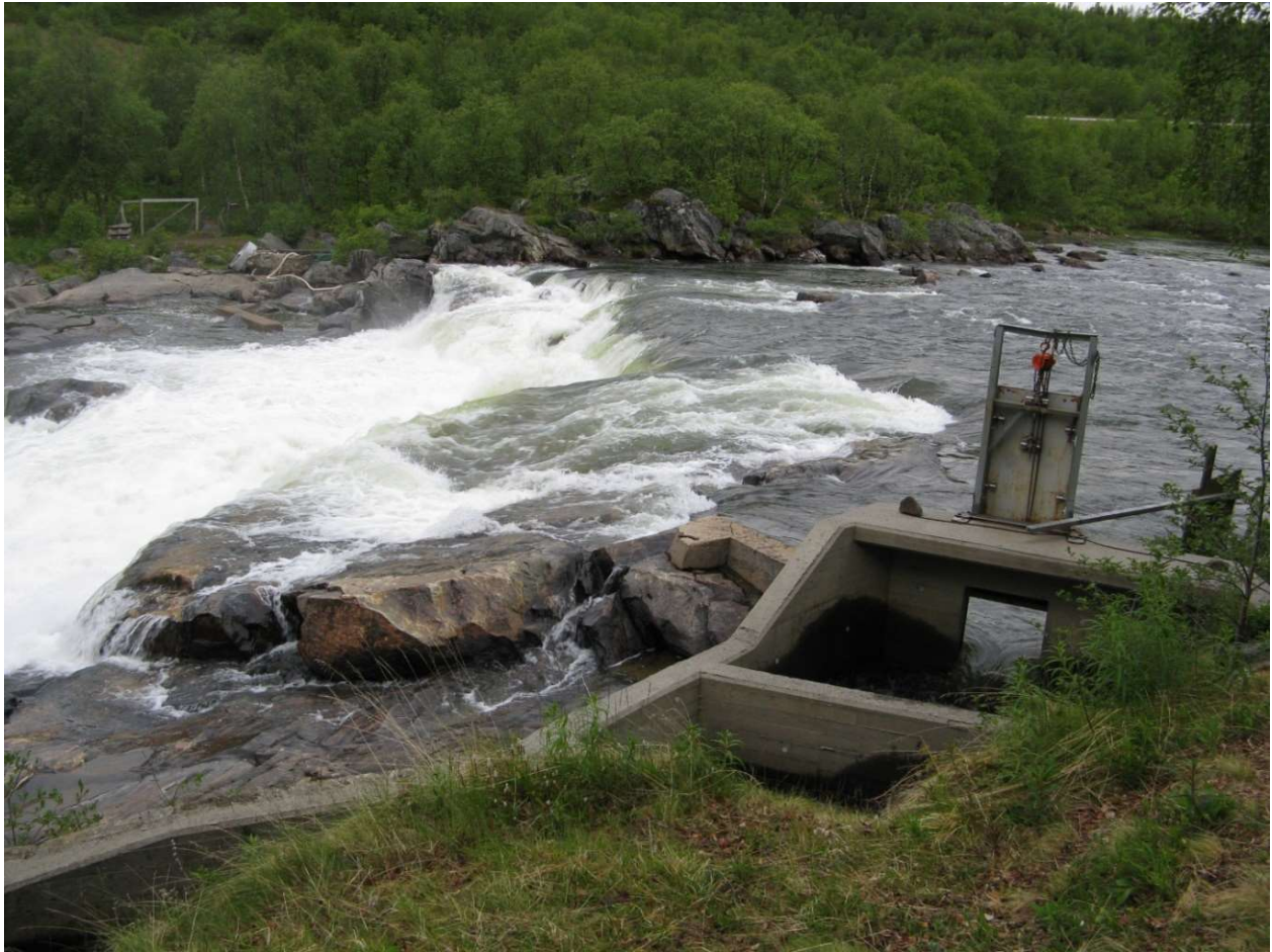
Foto 25. Høsten 2000 ble de to øverste kulpene i fisketrappa ferdig, og samtidig ble det montert en mekanisk luke i utgangsåpningen for å regulere vannføringen. Foto Eero Niemelä.
