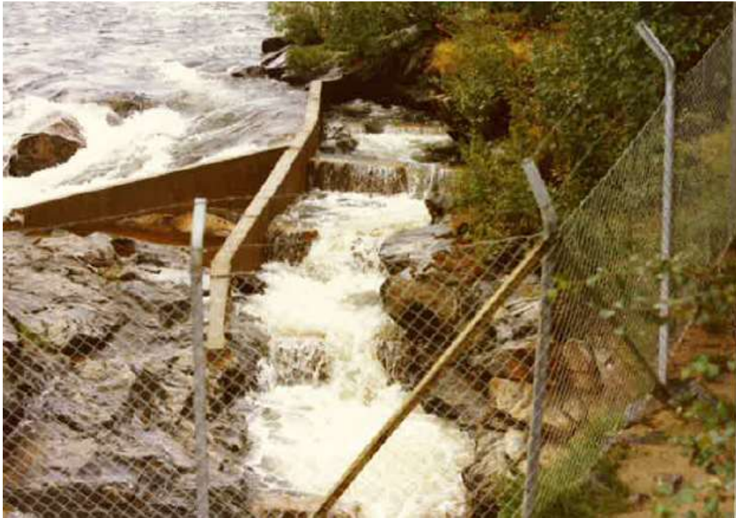
Foto 10. Fisketrappa i Skoltefossen i Neiden etter bygging av sikringsgjerde og den første ombyggingen i august 1974. Foto Kiril Sergejeff.
